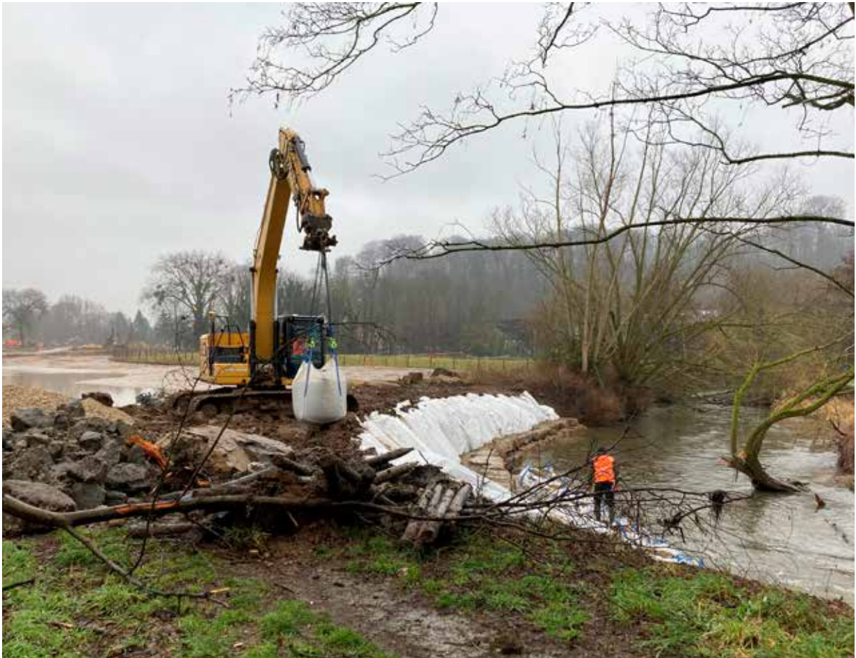
Aanleg bypass Geul bij Valkenburg
