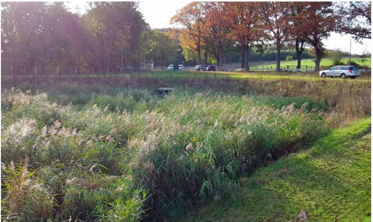
Riooloverstort Kerkrade met opvangbassin en ondergrondse filterinstallatie voor tegenhouden grof zwerfvuil
